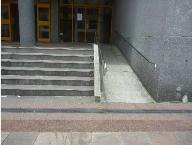
東側(臨曉峰館)坡道及扶手
