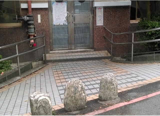
坡道及扶手(交誼廳出入口)
