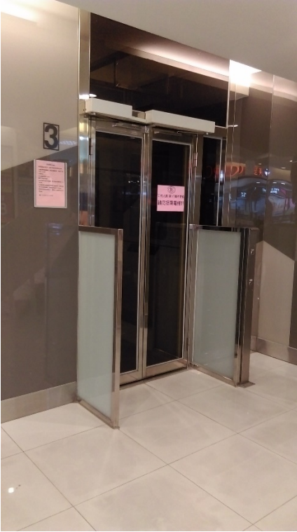
無障礙電梯 1-3 樓 1 座
